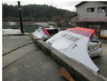
地震で防火塙が倒れた穴水町のSS
